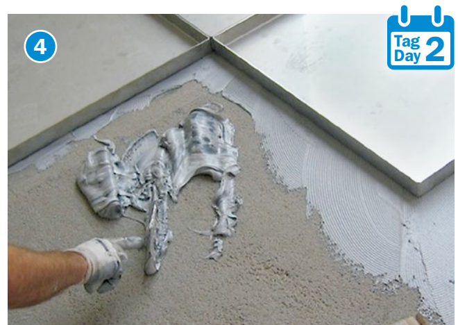
Kleber/Füller auftragen, Wannens einlegen ... Apply glue and place trays ... Répartir le ragréage/colle ... Aplicar el adhesivo o la masilla, colocar las cubetas ...
