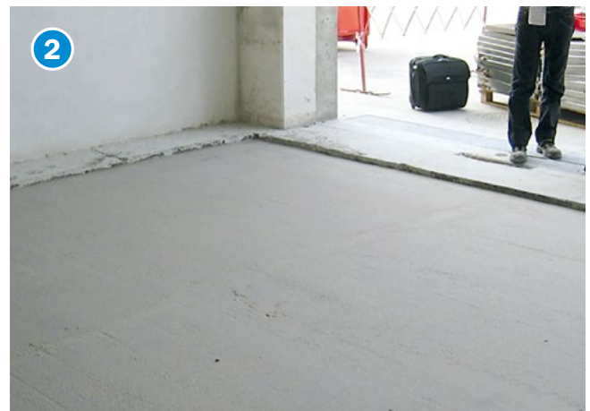
Flache und ebene Grube erstellen (siehe Schnittzeichnung ► A/B). Create flat and even pit (see sectional drawing ► A/B). Préparation du sol (selon plan de coupe ► A/B). Realizar una cavidad horizontal y plana (véase el plano de sección ► A/B).
