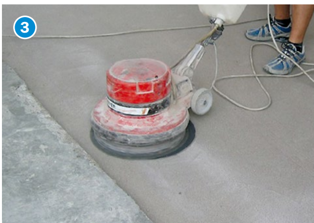
Oberfläche in der Grube glätten. Smoothen the surface in the pit. Polir la surface du sol. Alisar la superficie en la cavidad.
