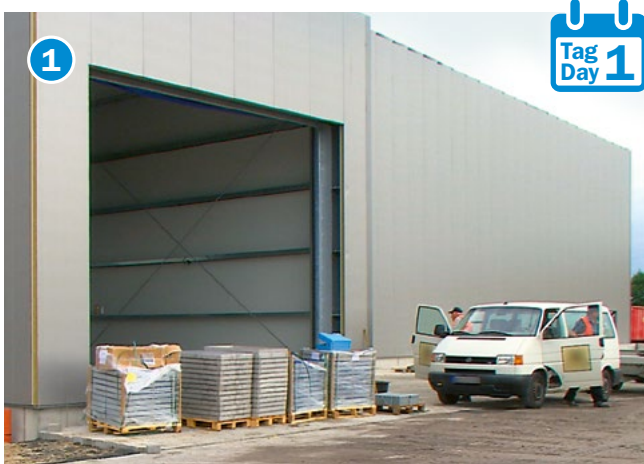
Vollständigkeit der Lieferung und korrekten Einbauort überprüfen. Check shipment for completeness and correct place. Vérifier la réception de la totalité de la commande à l'endroit d'installation prévu. Comprobar la integridad del suministro y la ubicación correcta de montaje.
